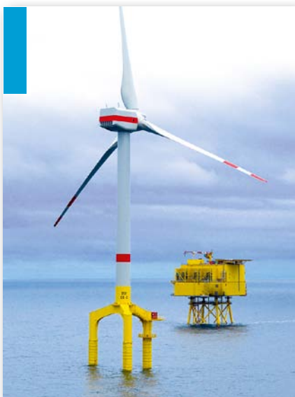
Figuur 19 BorWin1 offshore stopcontact (foto: TenneT)
